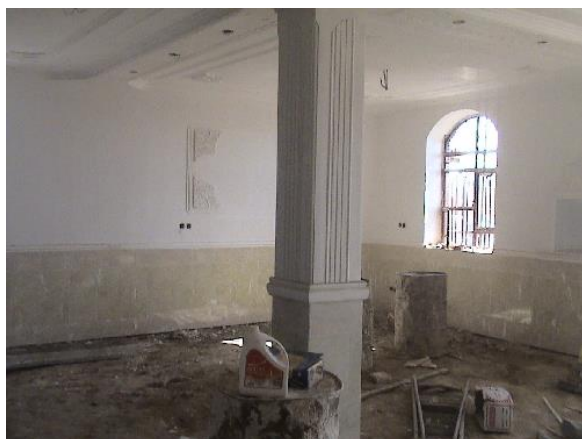
شکل ۸: گچ کاری و سنگ‌کاری نمای داخلی خانه
