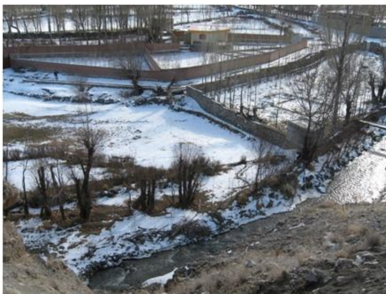
شکل ۶: محصور شدن مسیر رودخانه با زمین‌های کشاورزی و ویلاسازی در مقطع شماره ۵
