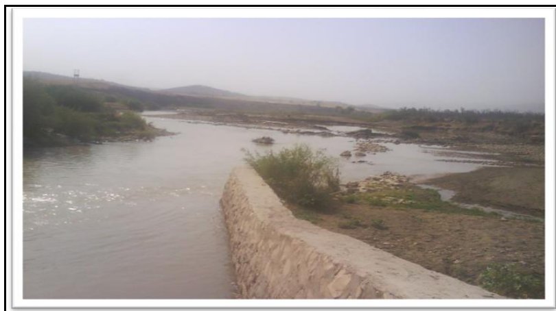
شکل ۹- ساخت سرریز بتنی و تغییر جهت مسیر رودخانه به علت ایستگاه پمپاژ آب در محل خمیدگی شماره پنج
